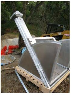
FlumeGate<sup>™</sup> positioned above frame
